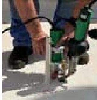
TRIAC DRIVE варит как на горизонтальных поверхностях,...
