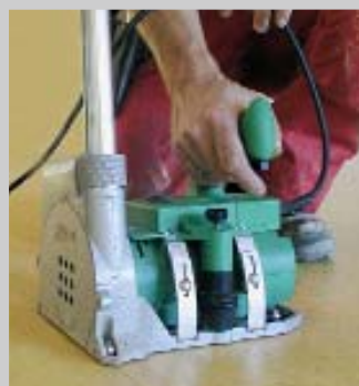
Шаг 1: разделка шва аппаратом GROOVER.
