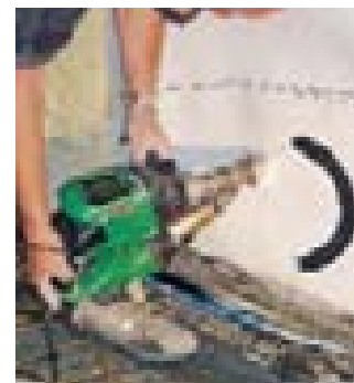
Удобный и надежный ручной сварочный экструдер WELDPLAST S2 при работе в туннелях.
