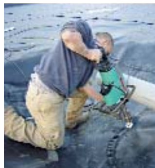
WELDPLAST S6 на монтажных работах при обустройстве полигонов.
