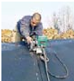
... на обустройстве полигона.
