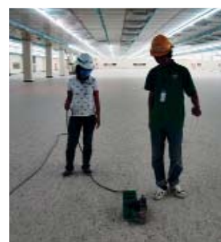
Сварочные швы отличного качества при использовании UNIFLOOR E (Вьетнам).
