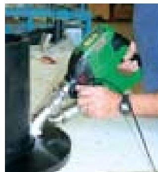
Сварка трубы аппаратом WELDPLAST S2
