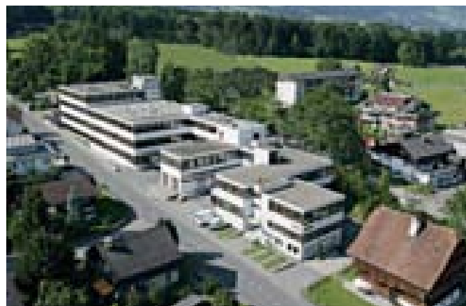
Производственные корпуса Leister Process Technologies, Кегисвиль, Швейцария
