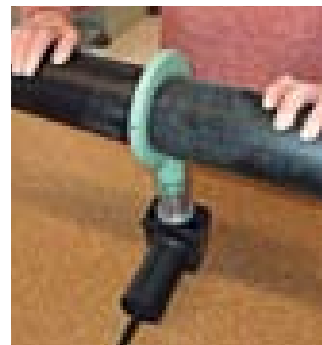
Сварка труб при помощи зеркальной насадки.
