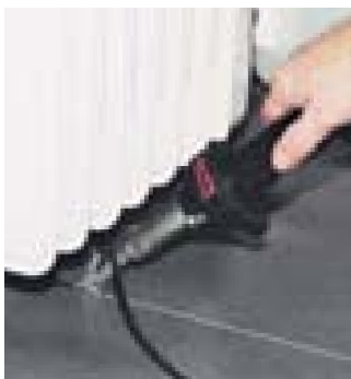
Маленький и легкий аппарат HOT JET S отлично подходит для сварки в узких и труднодоступных местах.
