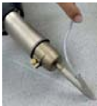
Сварка напольных покрытий ручным аппаратом TRIAC ST.
