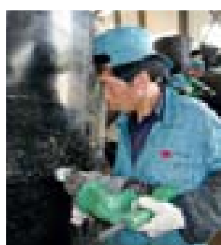
Экструдер FUSION 2 при сварке резервуара.
