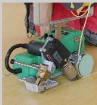
Шаг 2: сварка напольных покрытий аппаратом UNIFLOOR E.
