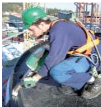
Мощный WELDPLAST S4 в работе.
